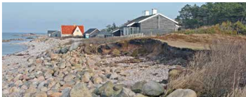
Bruddet på kystbeskyttelsen ved RVBL's grund ved Dybesø.
