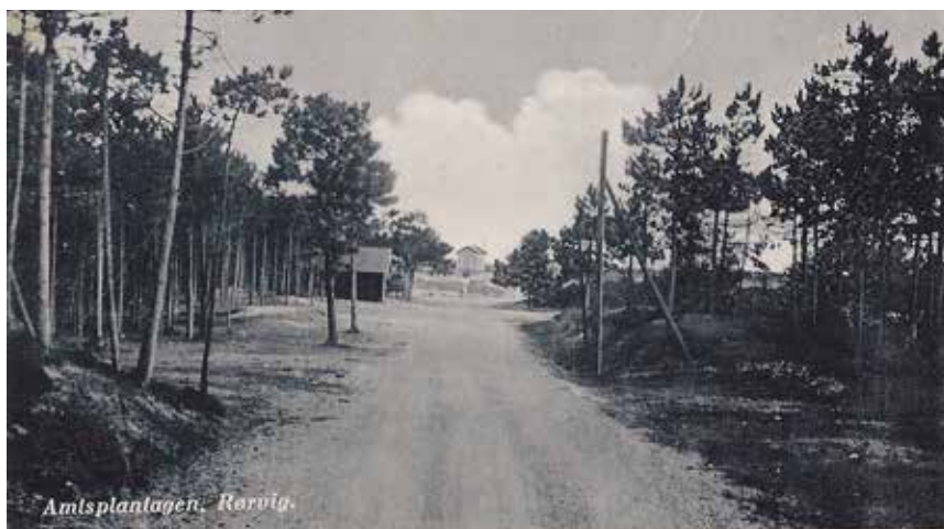
Kabelhuset ses midt i billedet.
