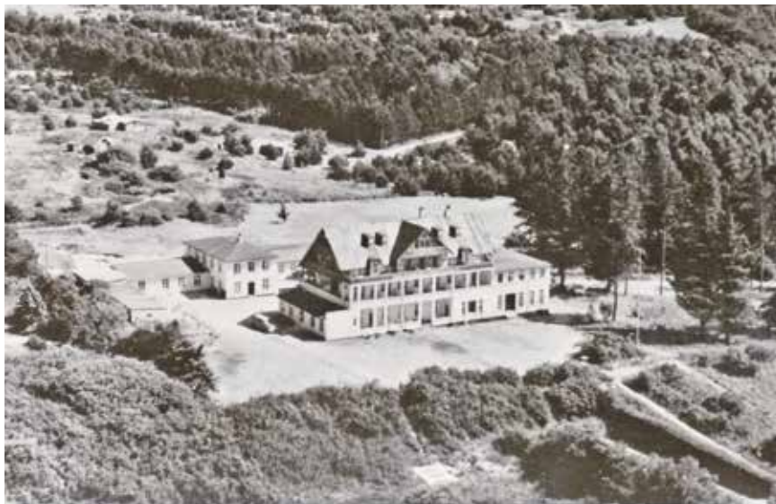
Den vestlige to-etages annektsbygning er opført. Det bagvedliggende areal som tidligere var naturområde er nu omdannet til et havelignende anlæg og mange træer syd for hotellet er fældet så der er dannet en plads der, hvor parkeringspladsen er i dag.
