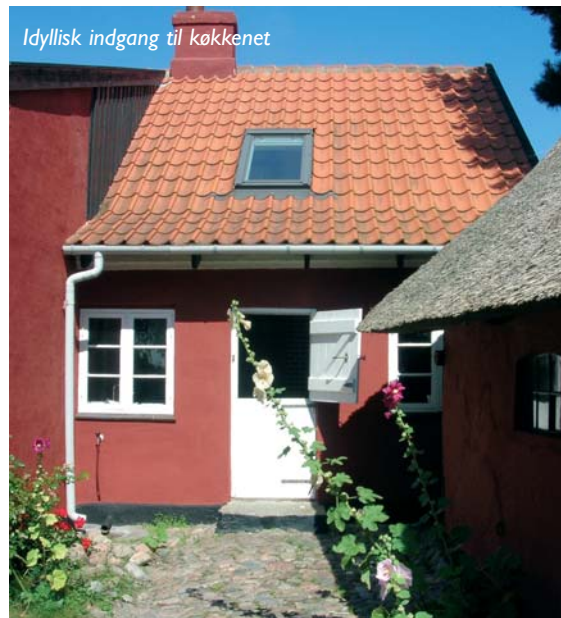
Husets tilbyggede karnap mod haven
