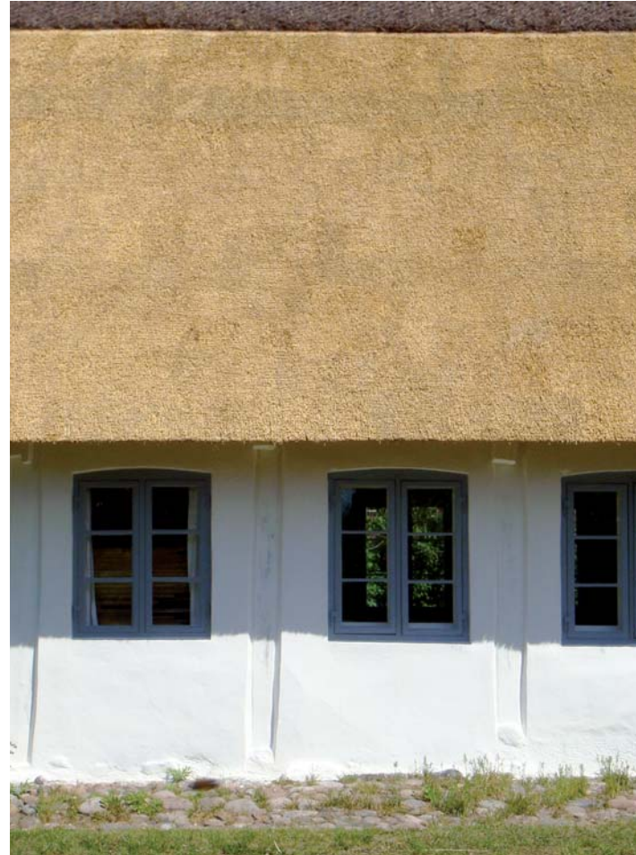
Sydfacaden før, under og efter renovering - nu uden karnapper i stråtaget og med fritlagte stolper.
