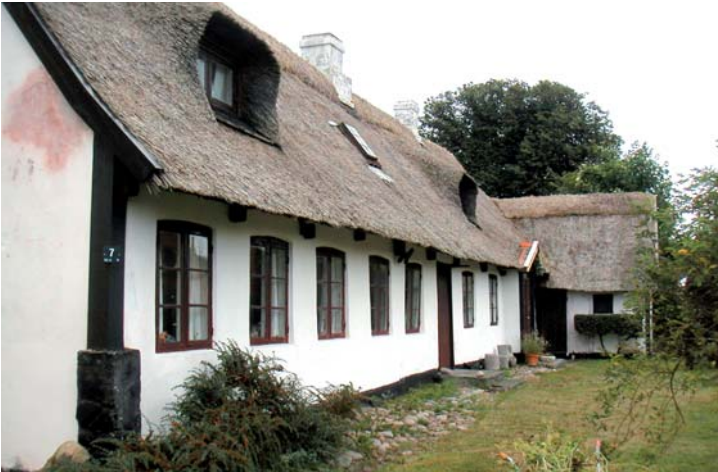
Sydfacaden før, under og efter renovering - nu uden karnapper i stråtaget og med fritlagte stolper.
