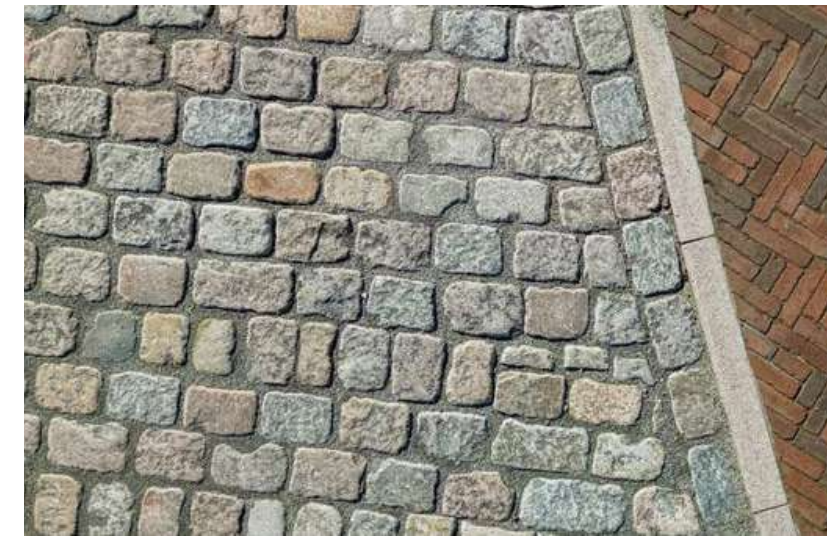
Brostensbelægning afgrænset af smal kantsten som møder teglklinter
