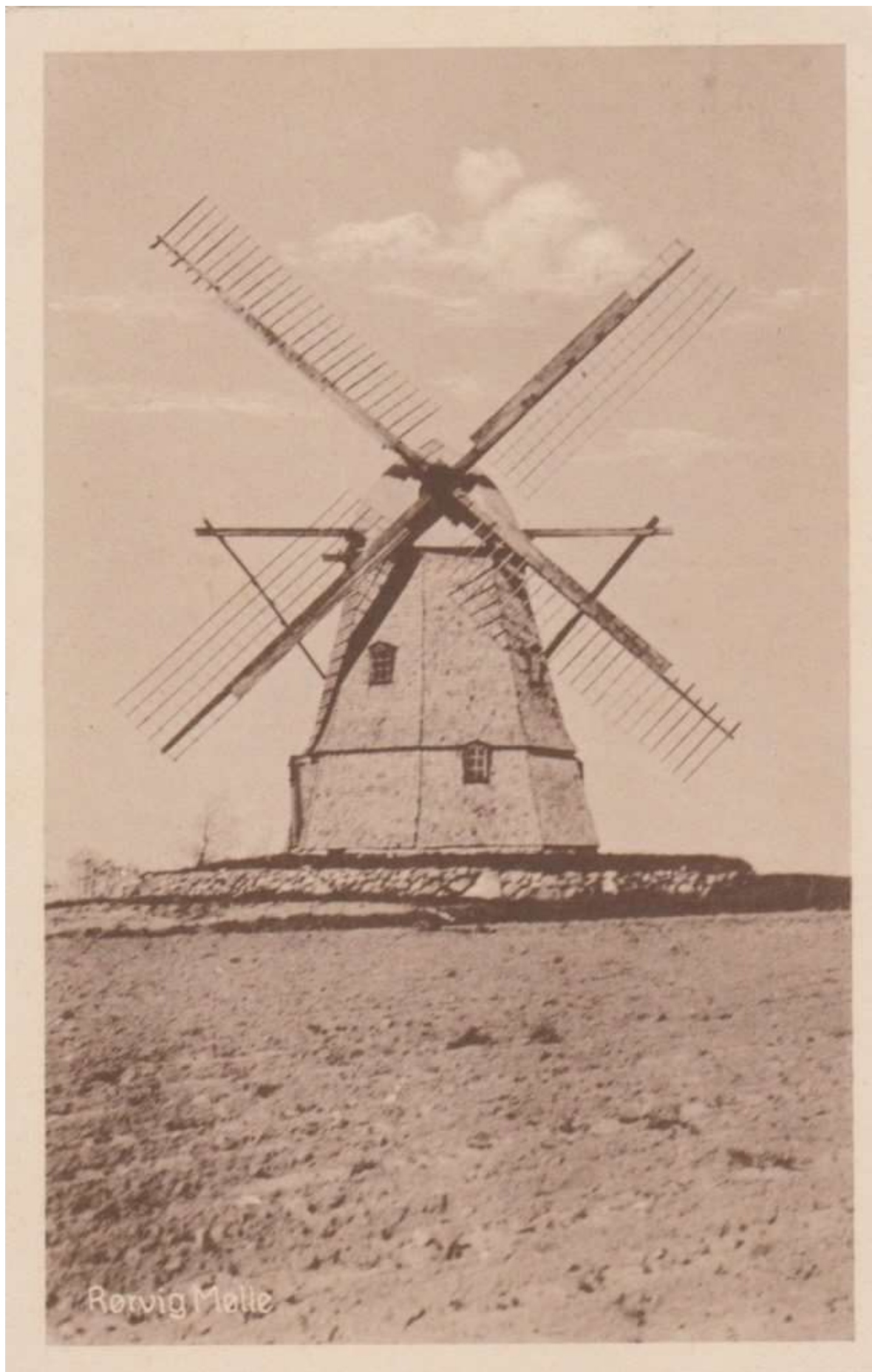
1933 Spån var udskiftet og kampestensgrund og stensætning var repareret i 1929-30
